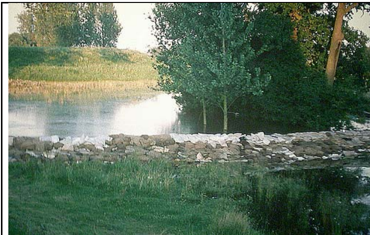
Foto: 37: Aufstau der Vorflut
