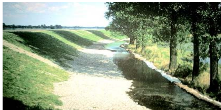
Foto 28: Auflast mit losen Kies
