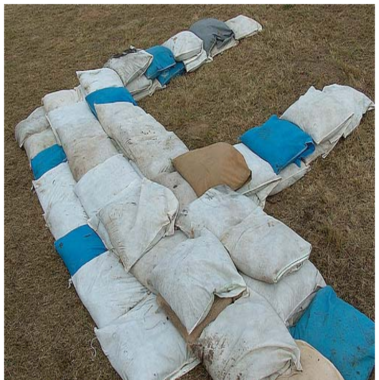
Bild 21: Kammkade am Übungsdeich in Seehausen
