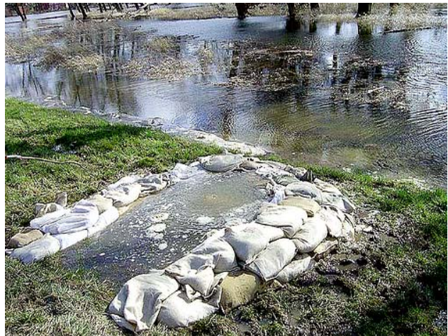
Foto 15: noch starker Wasseraustritt
