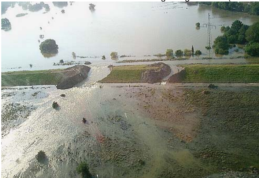
Foto:38, linker Muldedeich östlich Bitterfeld, bei Friedersdorf, Schlitzung des Deiches, damit das Wasser in der Goitzsche zur Mulde abfließen kann, August 2002
