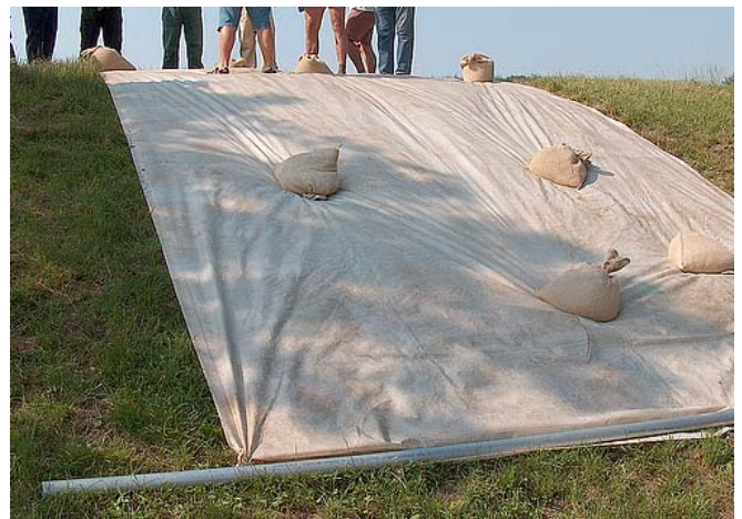
Foto 4: Folie nach dem Ausrollen
