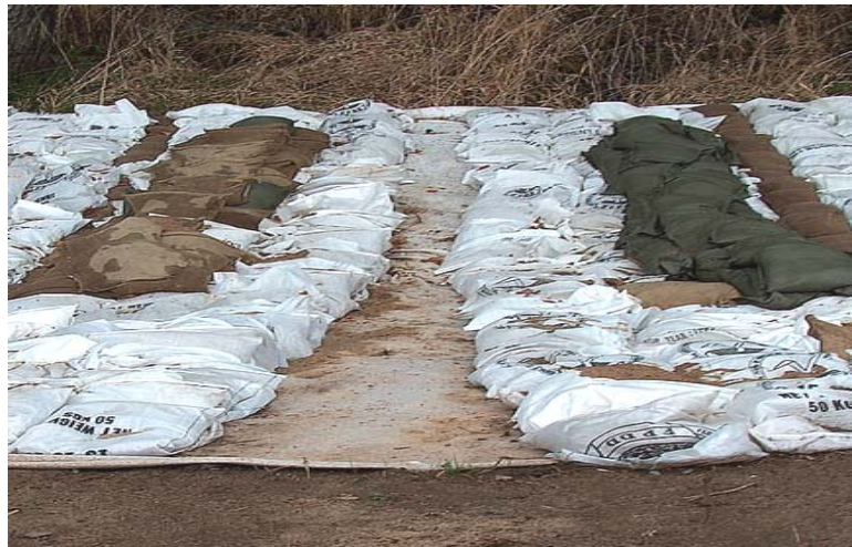
Foto 26: Auflast mit Vlies und Sandsäcken
