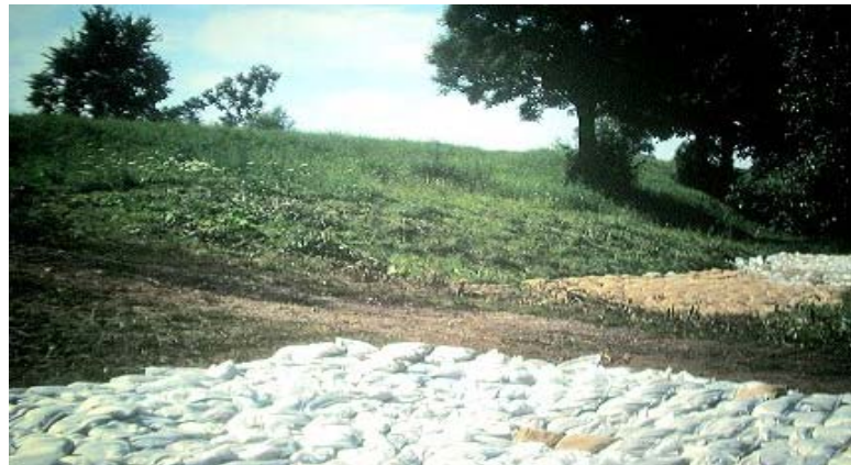
Foto 27: Auflast mit Kies in Sandsäcken
